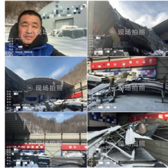
2025年1月28日，吉林省四平市某县出现暴雪天气，将某在建工程项目中的大型临建2号拌合站内的1号钢筋加工场屋面压塌，被保险人于2025年2月5日一早向保险人报案。我司公估师接到委托后，立即与被保险人联系并于当日进入现场进行查勘。经查勘确认，受损建筑为钢结构，整体尺寸为长90米、宽27米、檐口高度10.5米。本次事故是由于天气原因，屋面积雪深厚，导致两跨（12米长）屋面垮塌，一榀拱架完全垮塌、一榀拱架破损，屋面檩条部分变形破损，屋面阳光板及彩钢板完全变形破损，屋面彩钢板为单层彩钢板。
